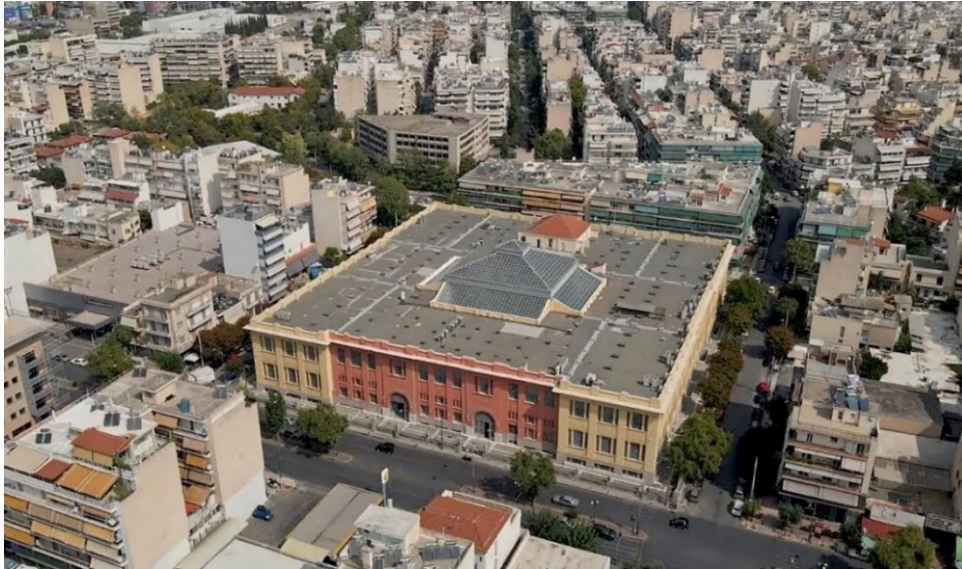
Εικόνα 9. Το πρώην Δημόσιο Καπνεργοστάσιο επί της οδού Λένορμαν στην περιοχή του Κολωνού.
