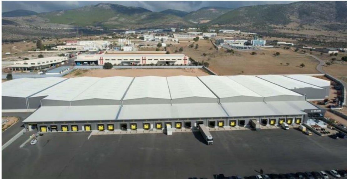
Εικόνα 7.10 Εταιρία διαμετακομιστικού εμπορίου στον Ασπρόπυργο. https://business.gr/prasino-fos-gia-tin-ependysi-logistics-se-akinito-tis-briq-properties-ston-aspropyrgo/
