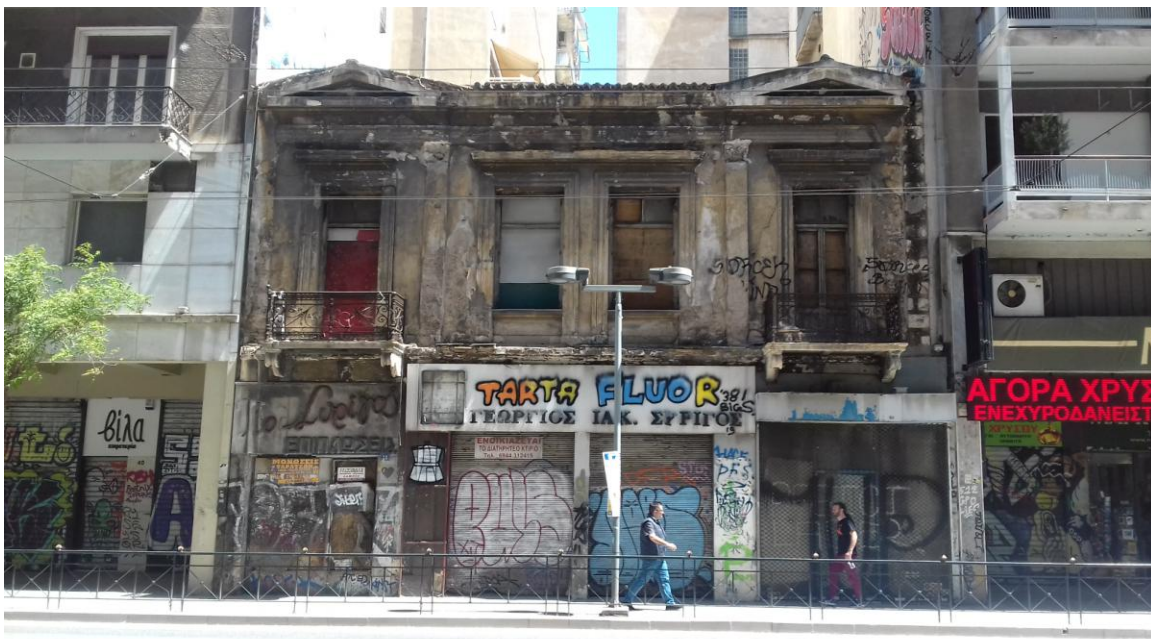
Εικ. VII Αναπαραγωγή φωτογραφίας με το κτήριο της οδού Πατησίων αρ. 38 (Λήψη: 30/4/2019). Πηγή: Προσωπικό αρχείο του ερευνητή.
