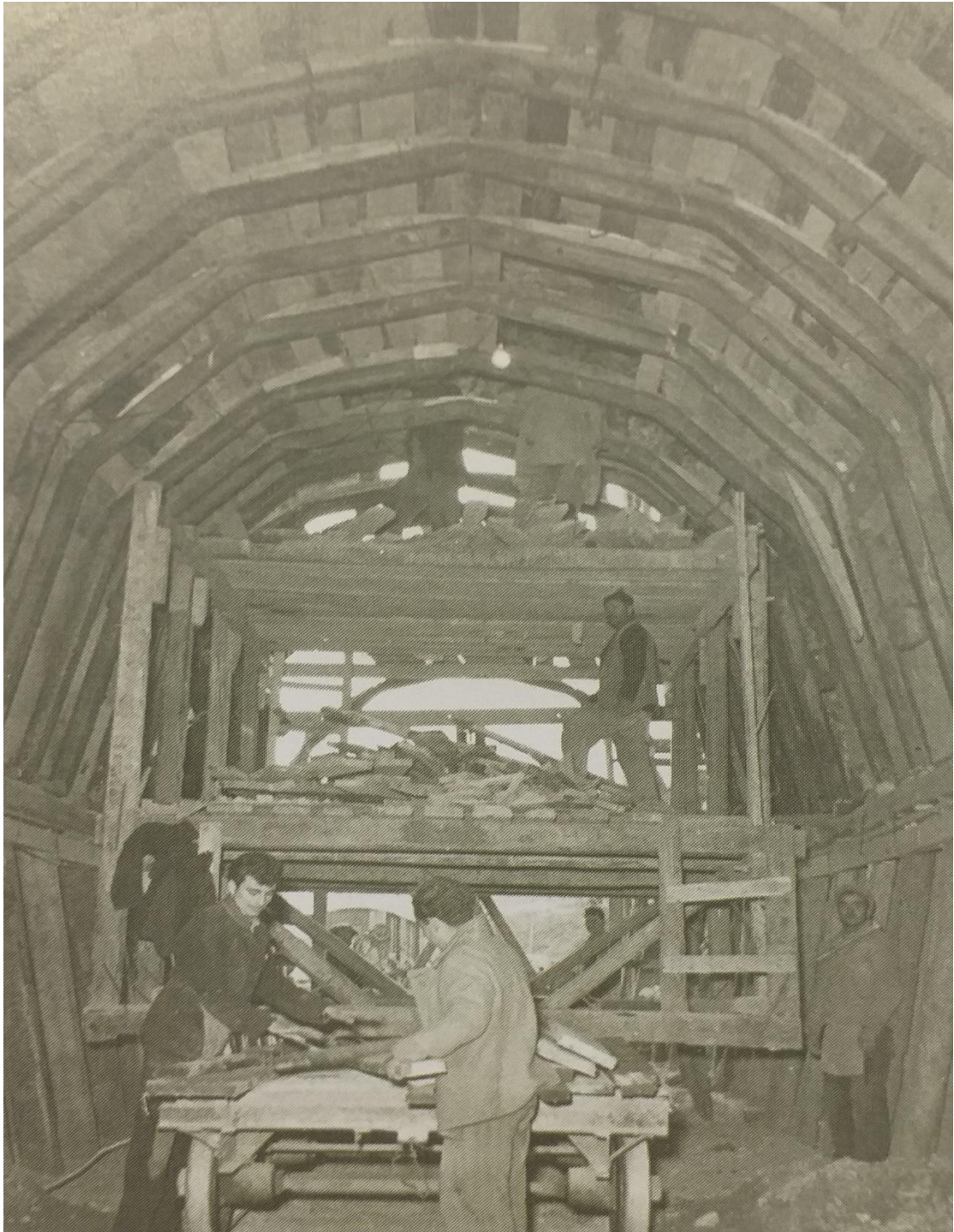
Εικ.1 Κατασκευή υπόγειας στοάς για την αποκατάσταση της σιδηροδρομικής συγκοινωνίας Αθηνών-Θεσσαλονίκης
